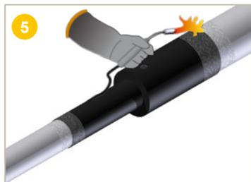
À l'aide d'un flambard, **préchauffer** les surfaces à recouvrir (*manchette + gaine 50 mm de chaque côté*) jusqu'à un minimum de **65°C**. **Contrôler** la température sur toute les surfaces à l'aide d'un thermomètre.
